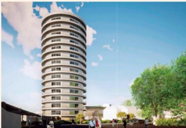
■總高15層樓的東洋木町用木材打造，為了提升防震能力，設計成獨特的圓形結構。
